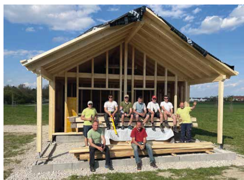
Die neu angelegte Streuobstwiese bekommt ein Lager- und Wirtschaftsgebäude. Den Bau stemmt der Verein in Eigenleistung.
