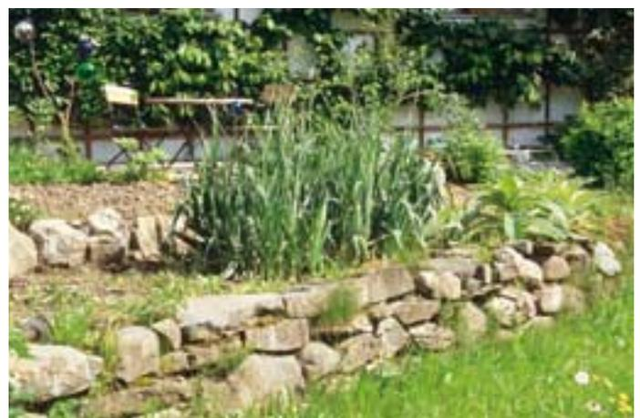
*Die Steine einer Trockenmauer haben nicht nur eine stützende Funktion. Sie geben die gespeicherte Wärme des Tages in der Nacht langsam wieder ab, wodurch eine positive Beeinflussung des Kleinklimas eintritt.*
