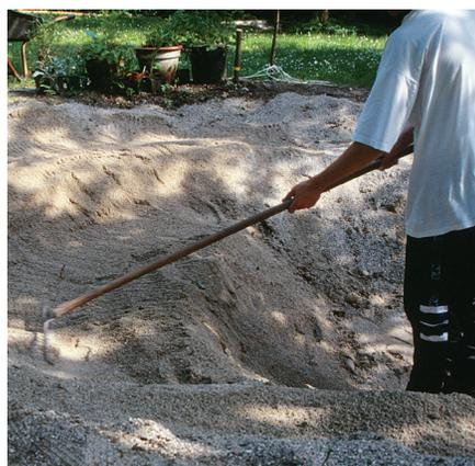
Sowohl Folie als auch Fertigteich werden mit einer Sandschicht unterfüttert, in der bereits die verschiedenen Tiefenzonen vorgeformt sind.
