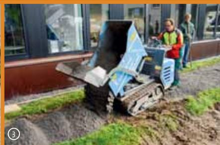
**3 Sand auffüllen.** Danach ungewaschenen Sand (0/4 mm) auftragen. Achtung: der Sand wird nicht eingefräst!
